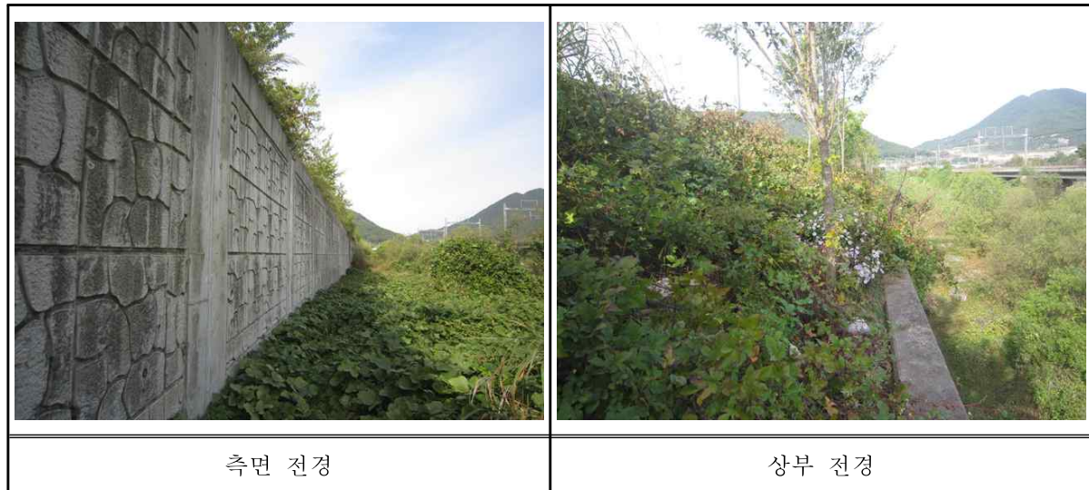
<그림 1.1.1> 콘크리트옹벽(9공구) 전경
