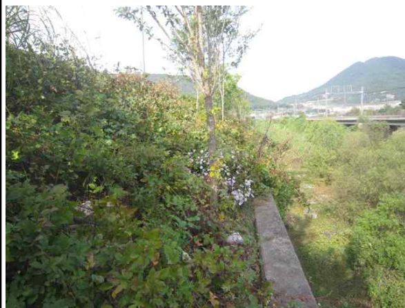
상단 성토부 전경
